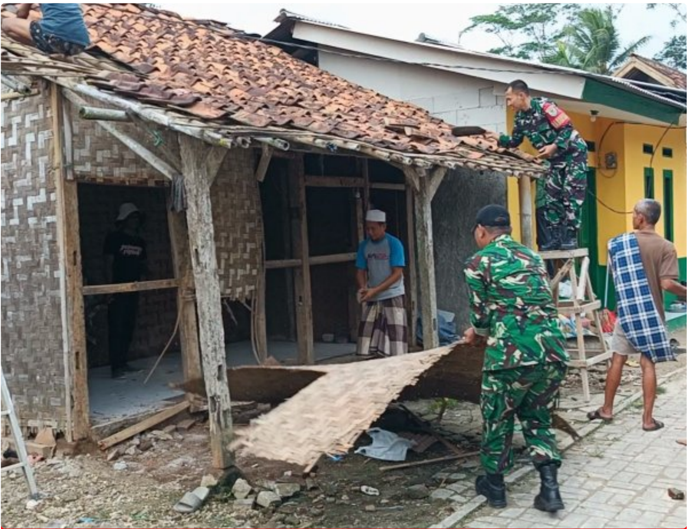
Pembongkaran Rumah Bapak Narmin
